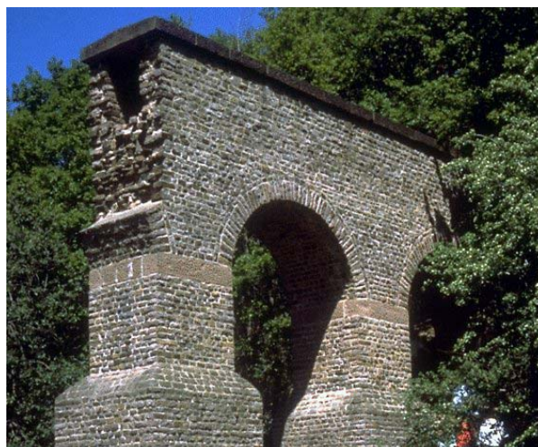
Bild 1 Römische Wasserleitung Quelle: Opus Caementitium
